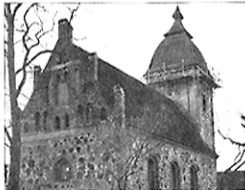
Die Gortzer Kirche ist ein spätgotischer Feldsteinbau mit Backsteinakzenten. Akuter Sanierungsbedarf besteht an den Decken- und Dachkonstruktionen des Kirchenschiffes und des Turmes. Durch die großzügige Finanzspritze kann die Sanierung bald losgehen und die Kirche gerettet werden.
